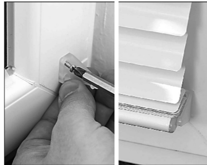
Kiinnitä alalistan tuulilukko E ikkunapuitteeseen tai oveen ruuveilla C ja kiinnitä alalistan päädyt tuulilukkoon.
