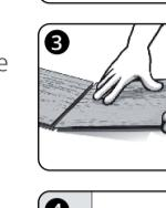
**3.** İlk sırayı döşerken kısa tarafları birleştirin. (resim 3). Her yeni panelin yayını, önceki panelin olugundan tam oturacak şekilde yerleştirin ve lastik çekici ile üstten vurarak birleştirin. Bu nokta iyi bir bağlantı için önemlidir.
